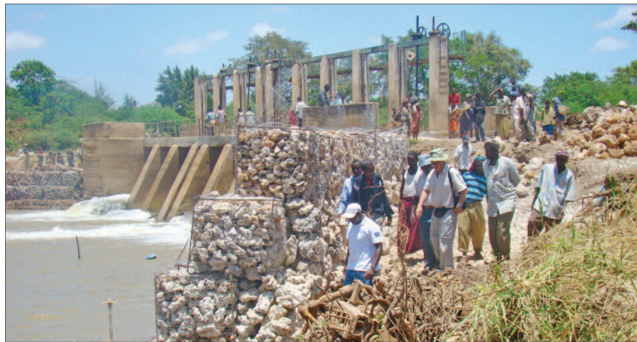
Szómália Shabelle folyójából duzzasztógátákkal terelik a vizet öntözőcsatornába
